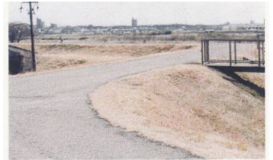
▲平成8年頃 くいちがい堤防 余所の地区では見られないが中切に1ヶ所、松河戸は東西に1ヶ所ずつあった。ここには大きな排水門があり、庄内川の水が増えたと自動で門が開き水は入らない。庄内川の水が引くと自動で門が開き部落内の水が流れでる。
